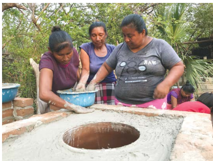
Figura 16. Colocación de barro blanco en comixcal FOTOGRAFÍA: KARLA S. GODÍNEZ NAVARRO (2019).
