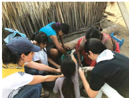
Figura 29. Brigadas de estudiantes del ITESO apoyan en la reparación del barro para el curado de los hornos comixcales FOTOGRAFÍA: KARLA S. GODÍNEZ NAVARRO (2019).
