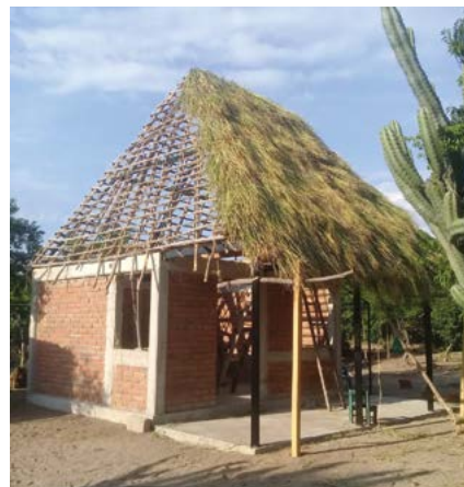
Figura 37. Tejido de palma nit en techo de vivienda híbrida
