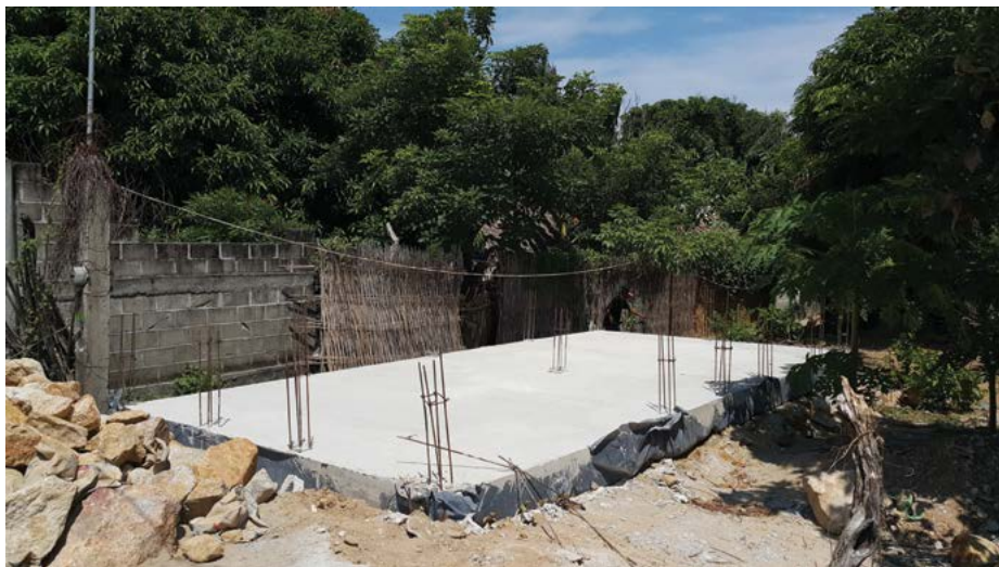
Figura 8. Ejemplo de cimentación reforzada en proceso de construcción FOTOGRAFÍA: ÓSCAR HUMBERTO CASTRO.
