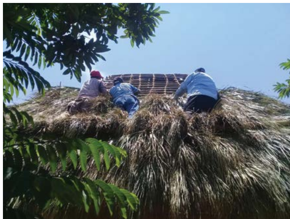
Figura 24. Fijación de las varas de mangle o iüm xiül de madera a la estructura de acero, y a la derecha tejiendo las hojas de palma nit en las viviendas híbridas
