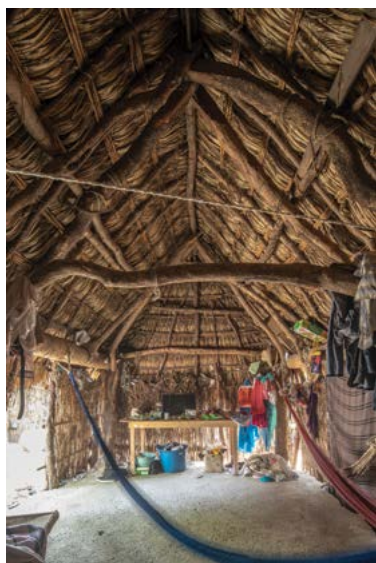
Figura 7. Vista del espacio interior o tiliüm de la vivienda tradicional ikoots FOTOGRAFÍA: ONNIS LUQUE (2019).
