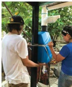
Figura 28. Estudiante y asesora del equipo técnico instalan filtro de primeras lluvias FOTOGRAFÍA: CARLOS EDUARDO ESTRADA CASARÍN (2018).
