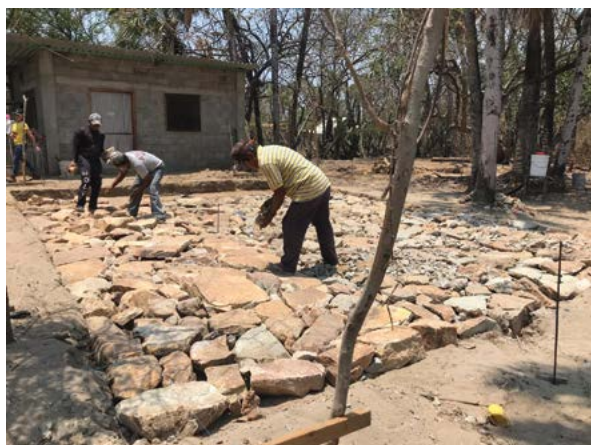
Figura 32. Equipos trabajando en tequio en la colocación de piedra FOTOGRAFÍA: KARLA S. GODÍNEZ NAVARRO (2019).
