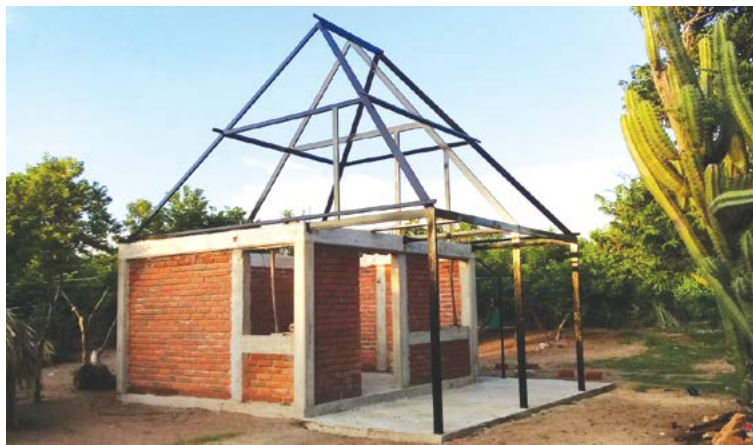
Figura 36. Estructura de acero sobre elementos de concreto armado
