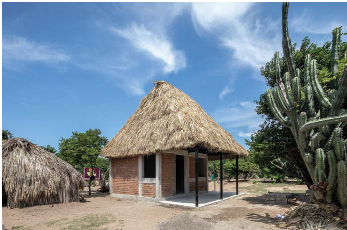
Figura 42. Vivienda híbrida con el techo recién terminado FOTOGRAFÍA: ONNIS LUQUE (2019).
