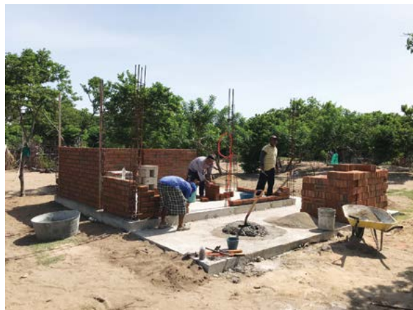
Figura 34. Anclaje de castillo en losa de concreto armado y construcción de muros
