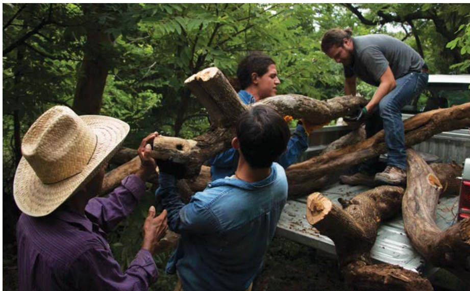
Figura 16. Brigada de recolección de troncos y horcones de madera para las estructuras de las cocinas tradicionales o ombiüm pow , realizada entre pobladores ikoots, estudiantes y asesores del ITESO (2018)
