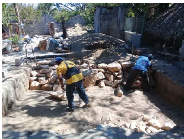
Figura 21. Jornadas de trabajo en tequio para la excavación, retiro de material y colocación de piedra FOTOGRAFÍA: CARLOS EDUARDO ESTRADA CASARÍN (2018).
