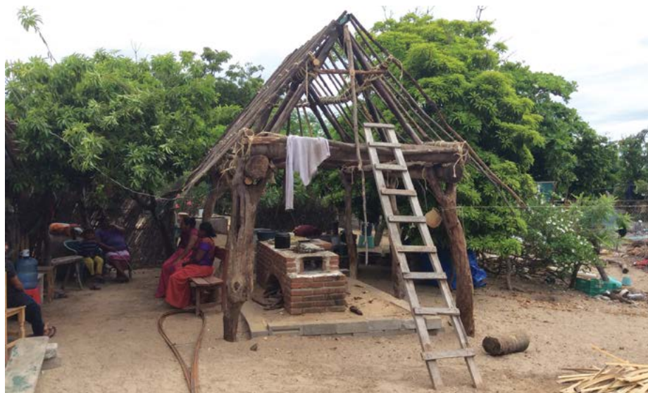
Figura 17. Cocina tradicional ikoots con estructura de madera con base en marcos rígidos de postes y horizontales con iüm xiül colocados en forma diagonal en su parte superior
