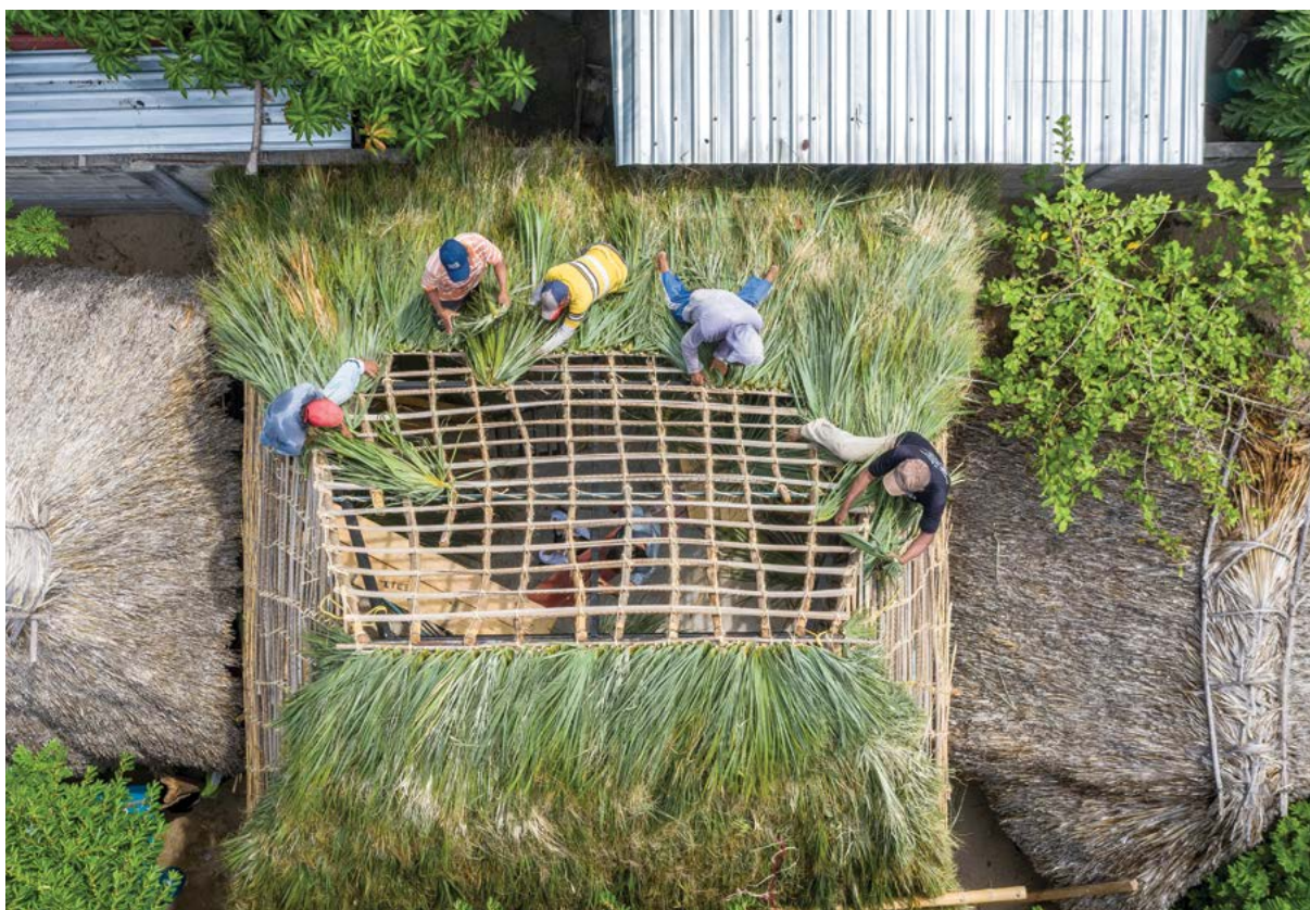
Figura 41. Maestros tejedores ikoots trabajan en el techo de una vivienda híbrida FOTOGRAFÍA: ONNIS LUQUE (2019).
