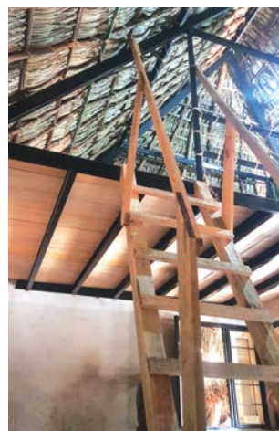
Figura 38. Instalación de tapancos, escaleras y barandales de acero, madera y fibras vegetales
