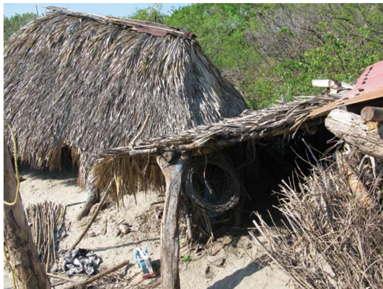
Figuras 7A y 7B. Hundimiento de viviendas con diversa tipología; nótese que el cuarto no presenta fisuras visibles a pesar del desplazamiento (Figura 7B)
