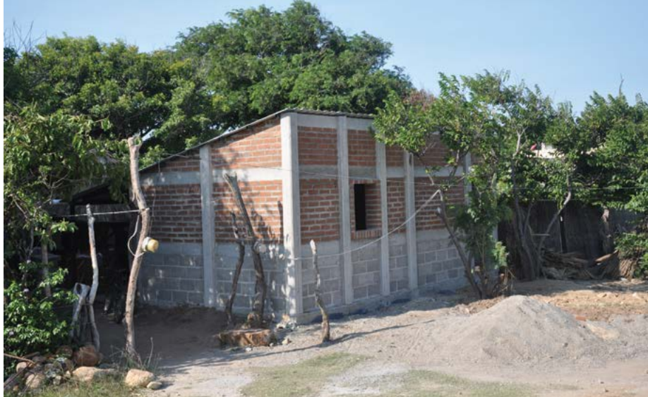
Figura 9. Ejemplo de vivienda entregada en la primera etapa
