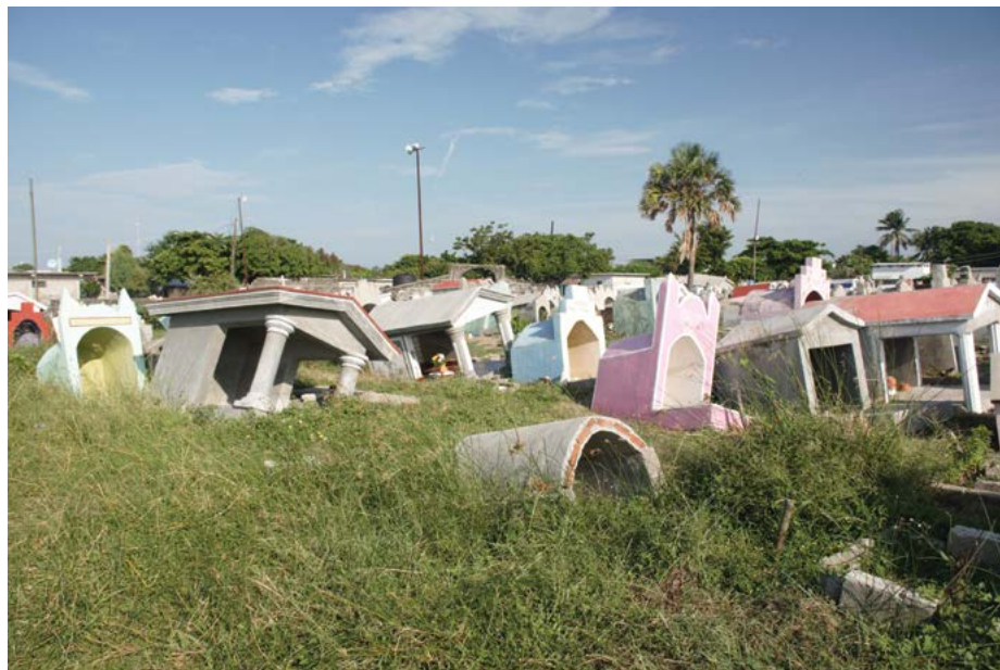
Figura 5. Losas del panteón de San Mateo del Mar tras los sismos y el efecto de licuación del suelo FOTOGRAFÍA: ÓSCAR HUMBERTO CASTRO.
