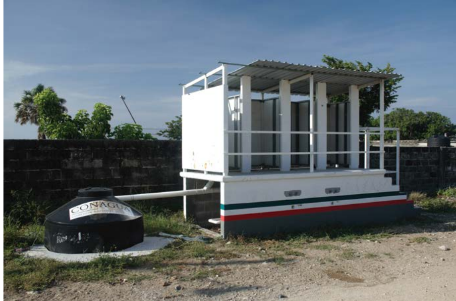
Figura 3. Ejemplo de letrinas comunitarias instaladas en San Mateo del Mar en respuesta a los daños a los servicios de agua y drenaje
