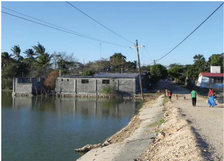
Figura 2. Vista en cruce de laguna en San Mateo del Mar
