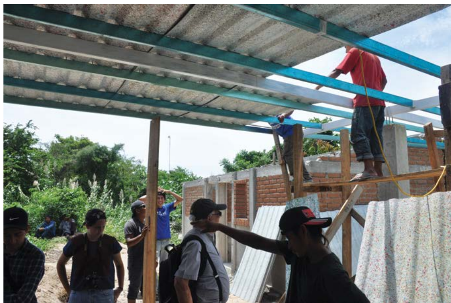
Figura 1. Colocación de lámina en la ejecución del proyecto piloto
