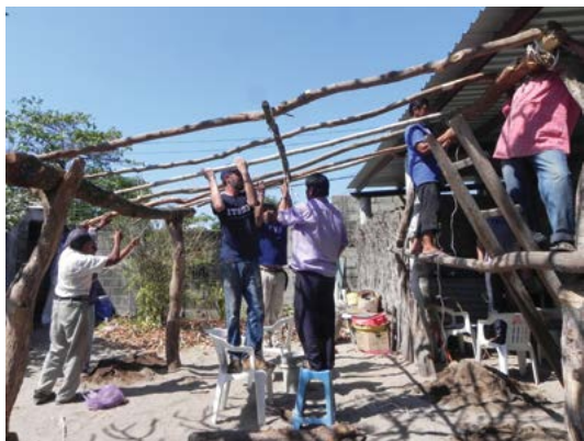
Figura 14. Taller de armado de estructura de madera con maestros tejedores o apeat y asesores del equipo técnico
