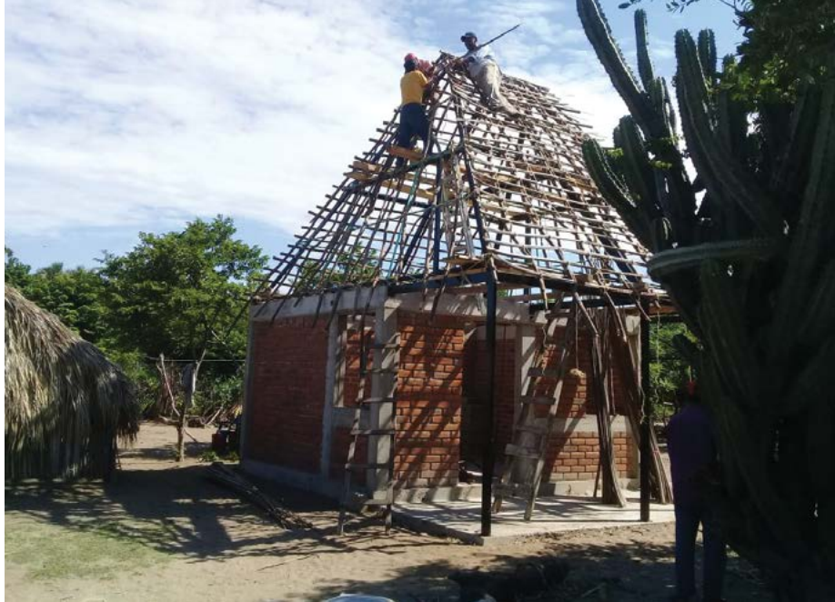
Figura 20. Fijación de varas de mangle o iüm xiül en estructura de acero FOTOGRAFÍA: CARLOS EDUARDO ESTRADA CASARÍN (2019).
