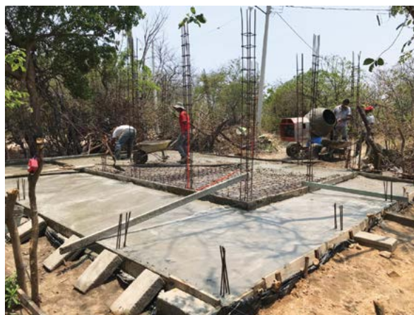
Figura 33. Colado de losa de cimentación antisísmica FOTOGRAFÍA: KARLA S. GODÍNEZ NAVARRO (2019).
