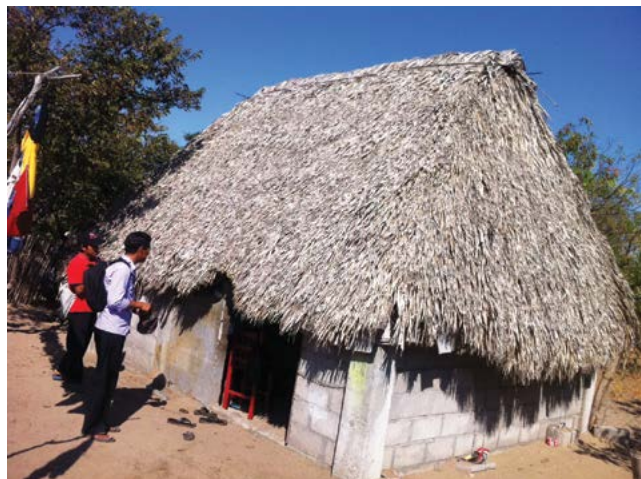
Figura 5. Vivienda compuesta por muros de block y concreto con cubierta de madera y palma nit, encontrada en los recorridos del equipo técnico FOTOGRAFÍA: CARLOS EDUARDO ESTRADA CASARÍN (2017).
