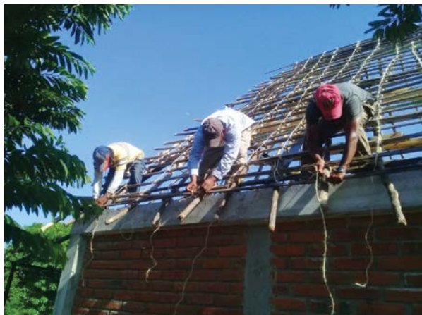
Figura 23. Jornadas de tequio de maestros tejedores colocando la estructura para el techo u omal iüm
