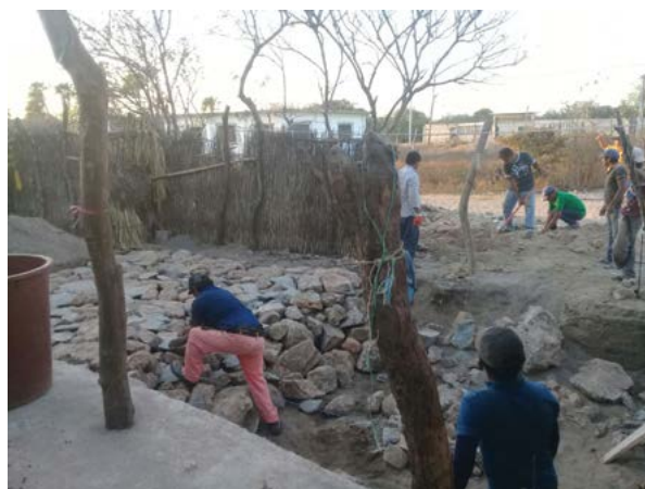
Figura 22. Jornadas de trabajo en tequio para la excavación, retiro de material y colocación de piedra FOTOGRAFÍA: GERARDO CANO DÍAZ (2018).
