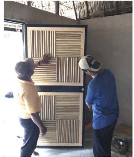
Figura 39. Acabado en puertas y ventanas FOTOGRAFÍA: CARLOS EDUARDO ESTRADA CASARÍN (2019).
