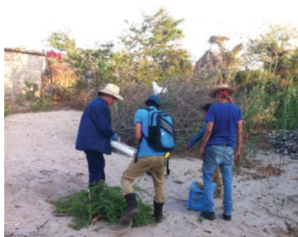
Figura 27. Brigadas de estudiantes del ITESO realizan sondeos con cono de penetración dinámica FOTOGRAFÍA: CARLOS EDUARDO ESTRADA CASARÍN (2018).
