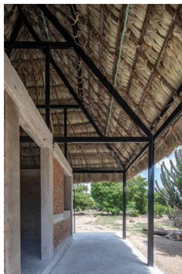
Figura 9. Vista del espacio exterior o mbas iüm de una vivienda híbrida FOTOGRAFÍA: ONNIS LUQUE, (2019).
