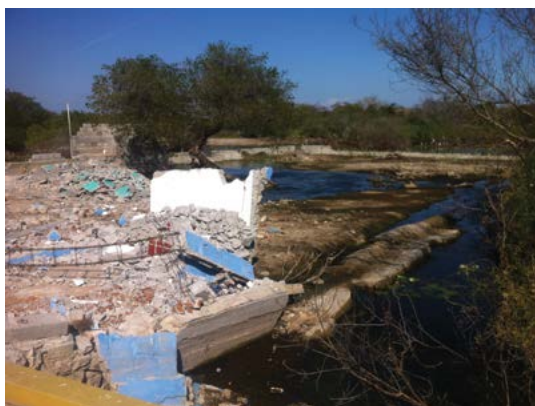
Figura 1. Edificaciones dañadas y entorno natural inundado en San Mateo del Mar
