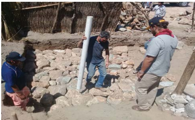
Figura 15. Taller de cimentación antisísmica con pobladores y el equipo técnico del ITESO
