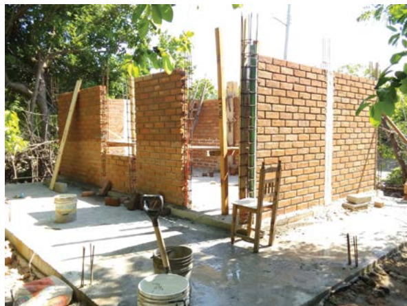
Figura 35. Construcción de muros aparentes de ladrillo
