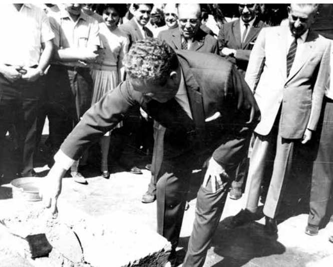
Imagen 3.5 Colocación de la primera piedra, 1962 Fuente: Archivo Histórico del ITESO.
